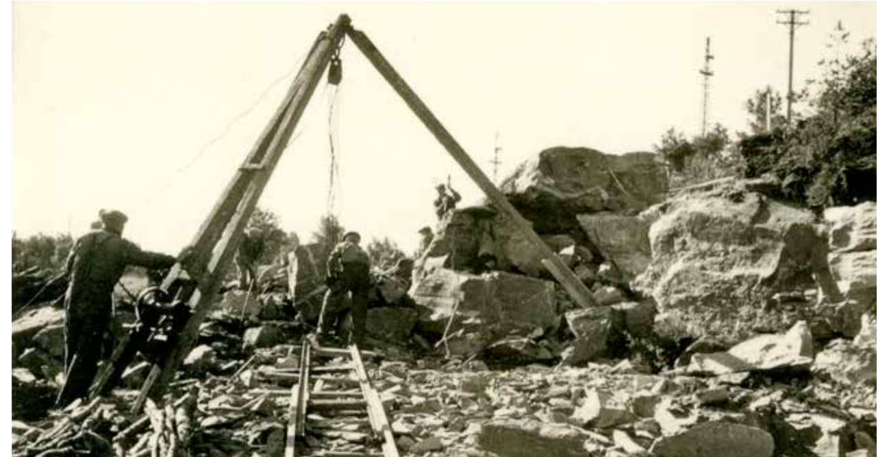
Norske arbeidere fra firmaet Betongbygg bygger vei til «Batterie Vara» i 1941.
