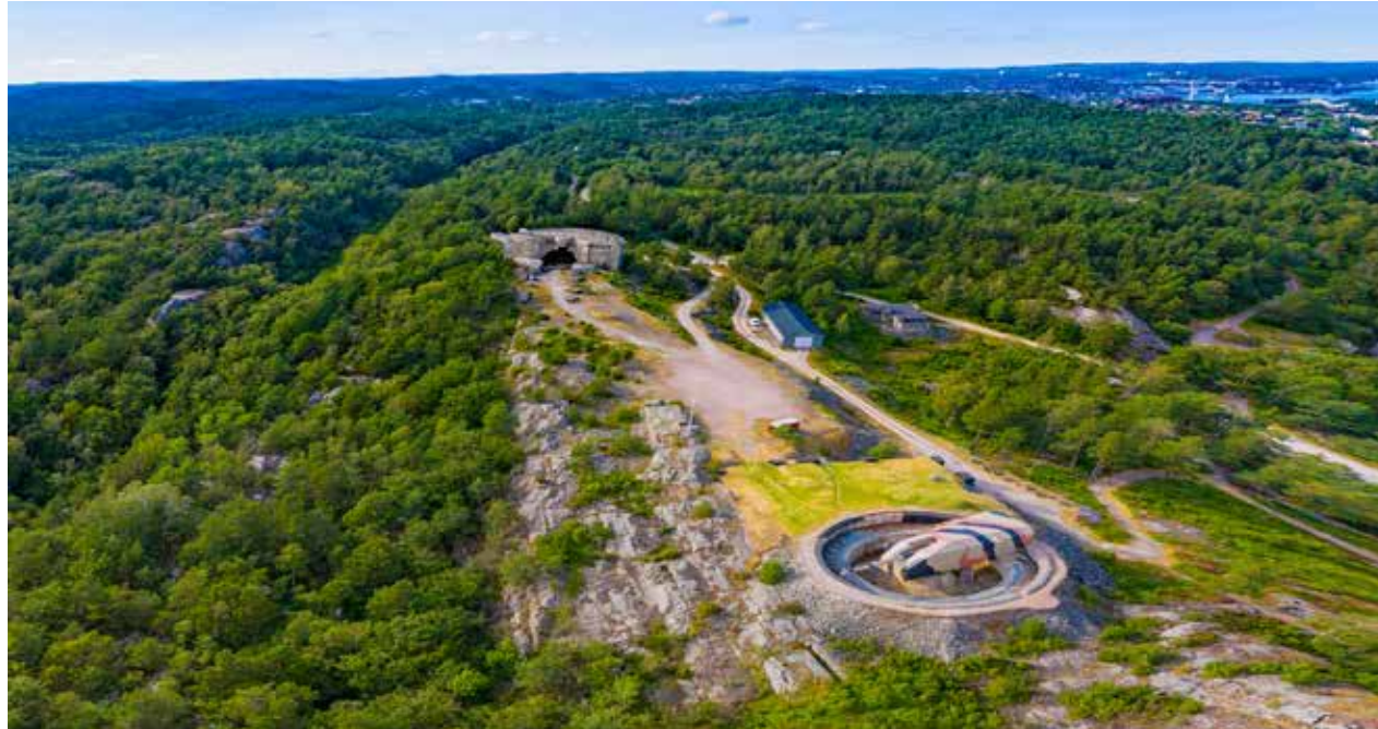
Store dimensjoner - «Batterie Varø» ved Kristiansand. Kystfortet skulle sperre Skagerrak og ble i hovedsak bygget av norske arbeidere. FOTO: STEINAR FURU
